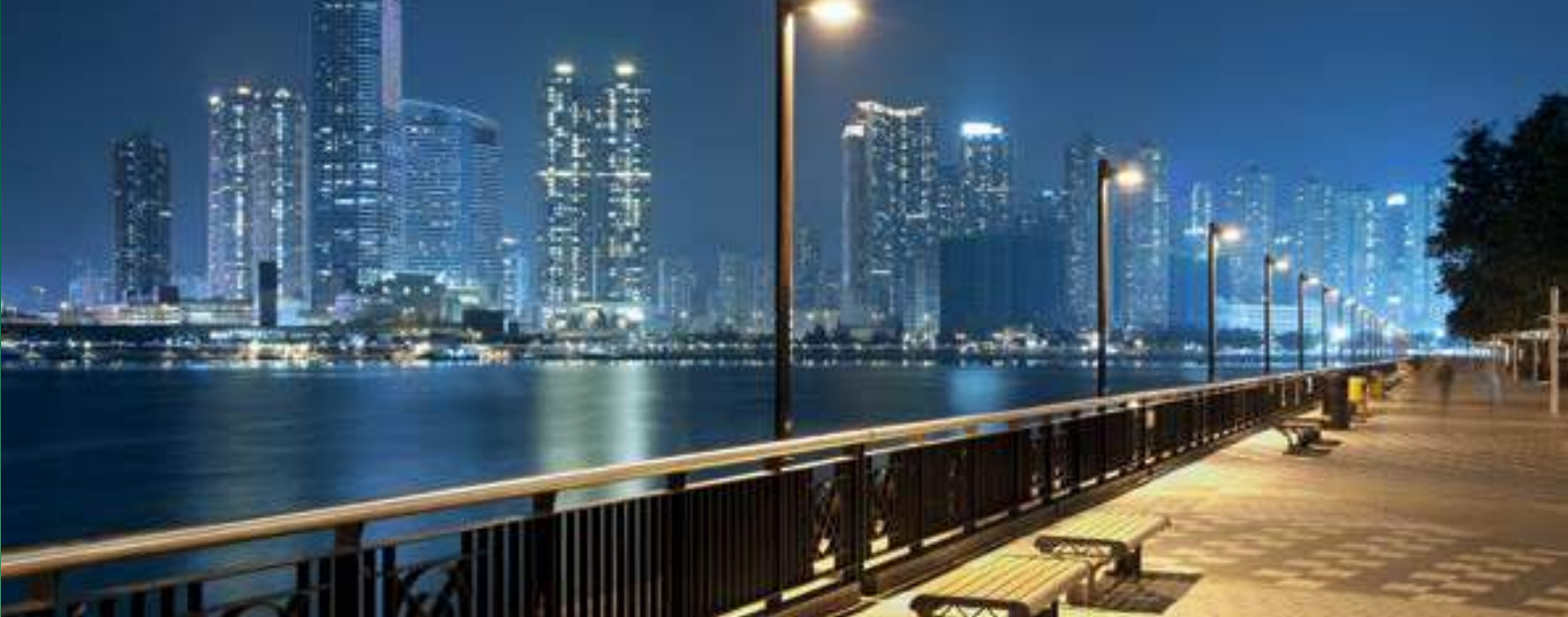
Luminaria Pública 15w
